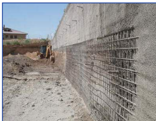
Detalle proceso constructivo sistema INGEONAIL
