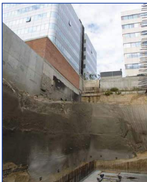
Contención provisional con sistema INGEONAIL
