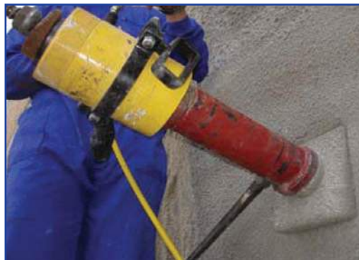
Detalle de tesado de anclajes
