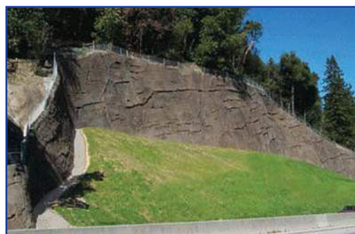
Ejemplo de contención de talud de carretera mediante sistema INGEONAIL y acabado estético
